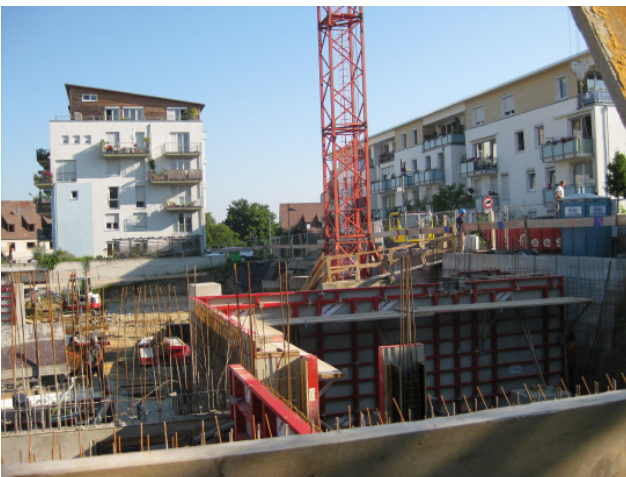
Der Bau des Hauses MOSAIK geht voran ... Im Hintergrund die Häuser WABE und MOBILE
